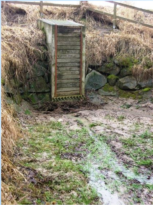
Viele kleine Becken im Kleingewässerbereich helfen Erosion u. Geschiebe zu vermeiden
